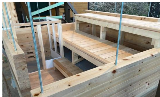
サウナ室施工
