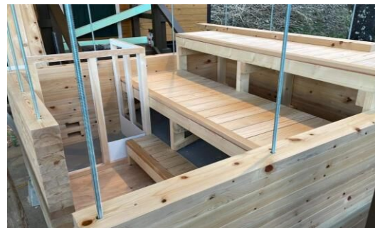
サウナ室施工
